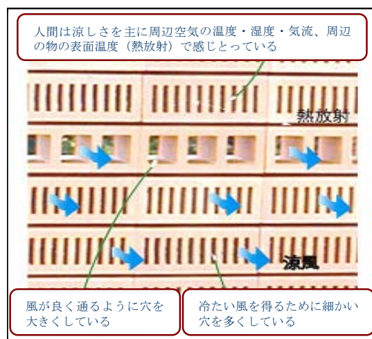
写真-6 梅干野先生が開発した保水性孔あきレンガを利用したパッシブクーリングウォール
